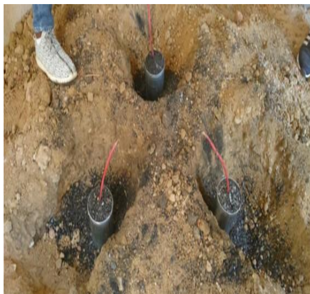
Fig. (11): Anodes lay-out.
