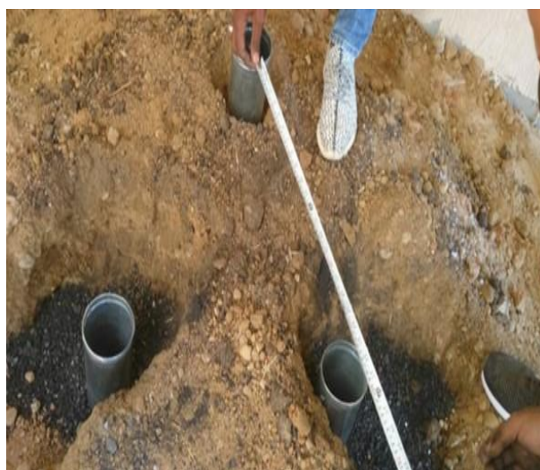
Fig. (12) Canister lay-out.
